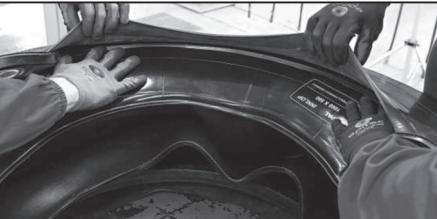
Posicione a aba do INNLOP abaixo do envelope, tome cuidado para não deixar nenhum ponto de vazão do ar entre o INNLOP e o envelope. Vire o pneu para a montagem da outra aba e repita a operação verificando novamente se a borracha degasadora está bem posicionada e sem dobras.
